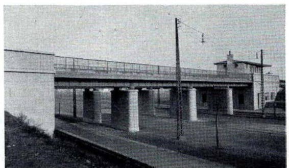
Fig. 52. Underføring ved LyngbyvejStation. Kontinuerlige Pladejernsdragere med Sporkasse af Jernbeton. Spændvidder 12,03 + 14,36 + 14,36 + 12,03 m. Fuldført 1931.
