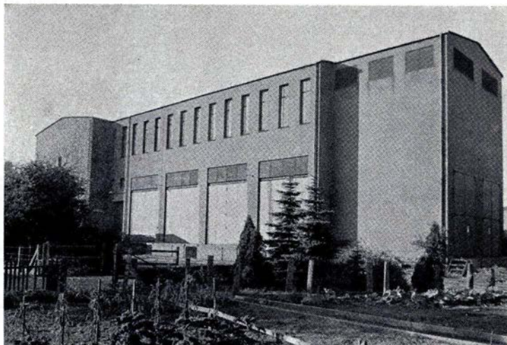
Fig. 227. Omformerstation ved Enghave.
