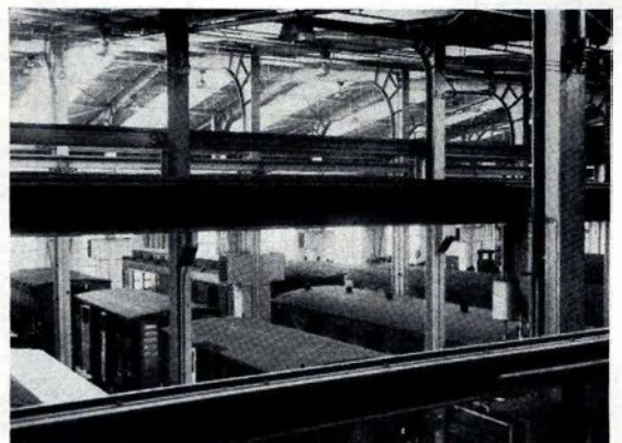
Fig. 223. Vognhallen, Aarhus Centralværksted, er opført 1941. Hovedfagene er udført af svejsede Staal-konstruktioner, DIMAX Nr. 65 i Hovedhallen med 20 Tons Kran og DIP Nr. 30 i Sidehallerne med 9 Tons Kraner. Ydervæggene er af Jernbeton. Vognhallen er ca. 52 m bred og ca. 12 m høj.
