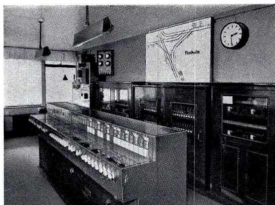
Fig. 134. Elektrisk Centralapparat med Sportavle.
