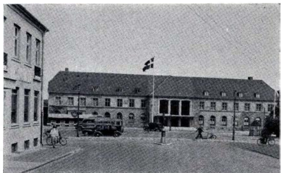
Fig. 207. Næstved Banegaard efter Ombygningen 1940.
