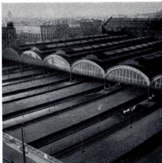
Fig. 183. Perronhal i København med Søjler af Jerngitter og Buer af sammensømmede Brædder. Tagfladen af Træ med Tagpap.
