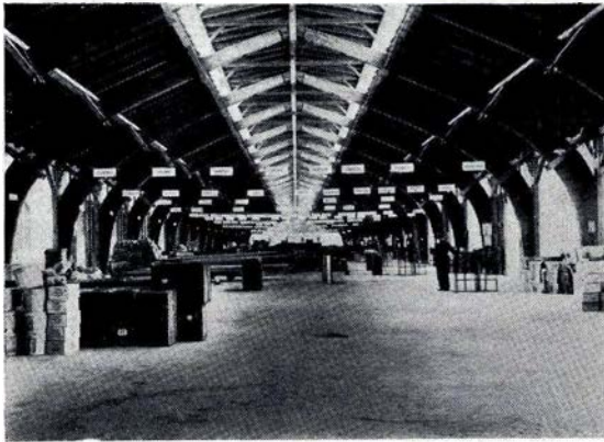
Fig. 230. Interiør fra Varehus paa Aarhus Station, opført ca. 1921. Taget bæres af Træbuer, udført af sammenlimede, bøjede Brædder (Hetzerbuer).
