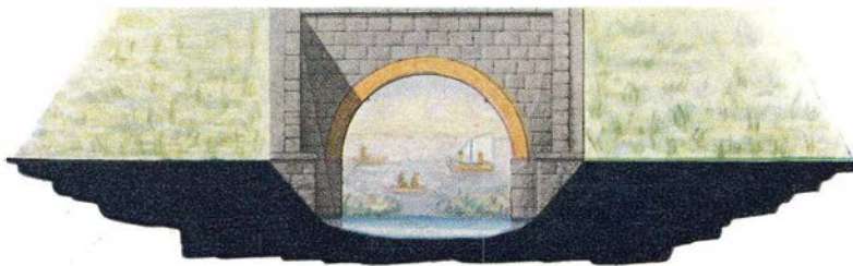
Øverst. Fig. 31. To Facadebilleder af »Røde Port«. Underføring for Korsør Landevej i Roskilde med Lysvidder paa ca. 12 Fod. Piller og Fløje af Mursten. Fuldført 1847, nedrevet 1936.
