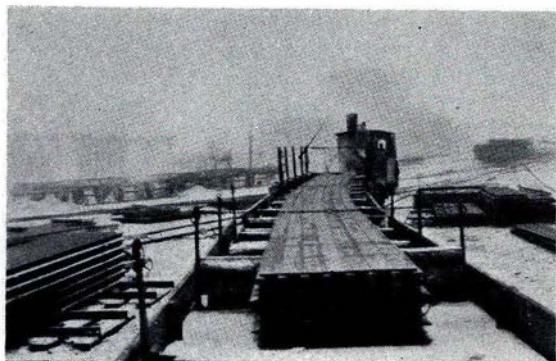
Fig. 93. Transport af 30 m lange Skinner. Skinnerne bøjer sig efter Sporets Kurver.
