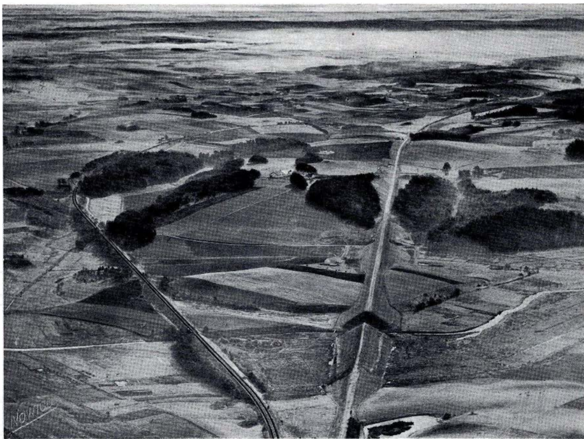
Fig. 6. Flyverfoto af Banestrækningen Skørping-Støvring taget fra Støvring mod Syd. Til venstre den oprindelige Banes Slyngning uden om Højdepartiet i Billedets Midte, til højre Jordarbejdet for det nye 2. Spor. I Forgrunden Passagen over Lindenberg Aa og Lindenberg Mose.
