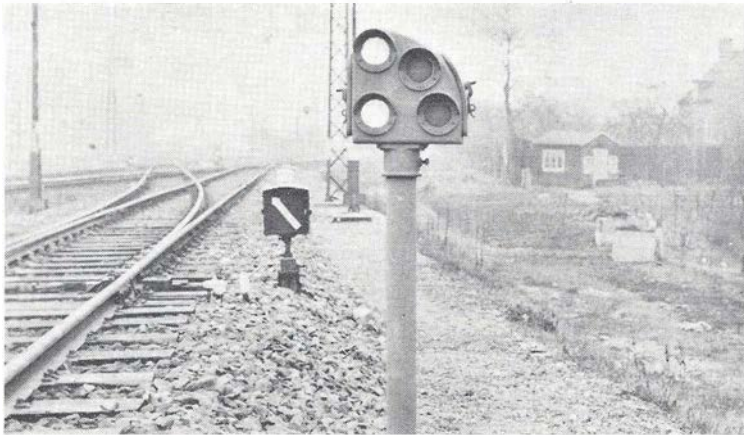
Sporskiftesignal: »Modgaaende Sporskifte stillet til afvigende Spor«. Dværgsignal: »Forbikørsel tilladt«.
