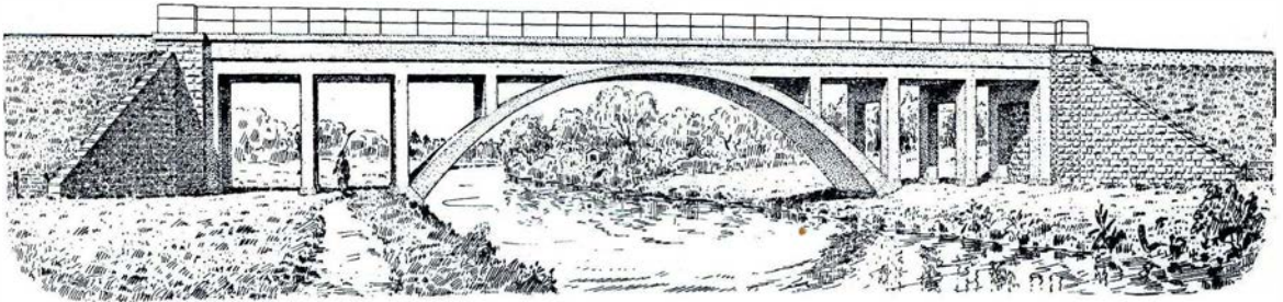
Fig. 50. Bro over Storaan i Holstebro. Jernbetonhvelving og -rammer med Spændvidder 3,85 + 3,75 + 21,60 + 3,75 + 3,85 m. Fuldført 1946.
