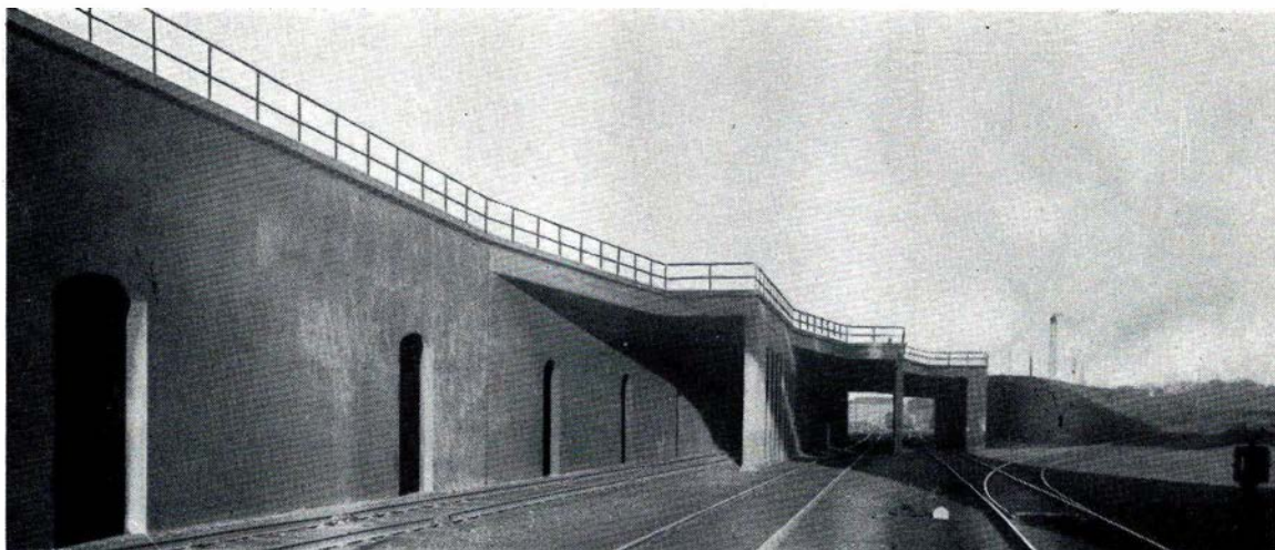
Fig. 53. Sporbærende Bro i Aarhus for 3 Spor over 3 Spor. Indstøbte Dragere. Lysvidder 4,60 + 4,60 + 4,60 m. Skæringsvinkel ca. 11°. Fuldført 1928.
