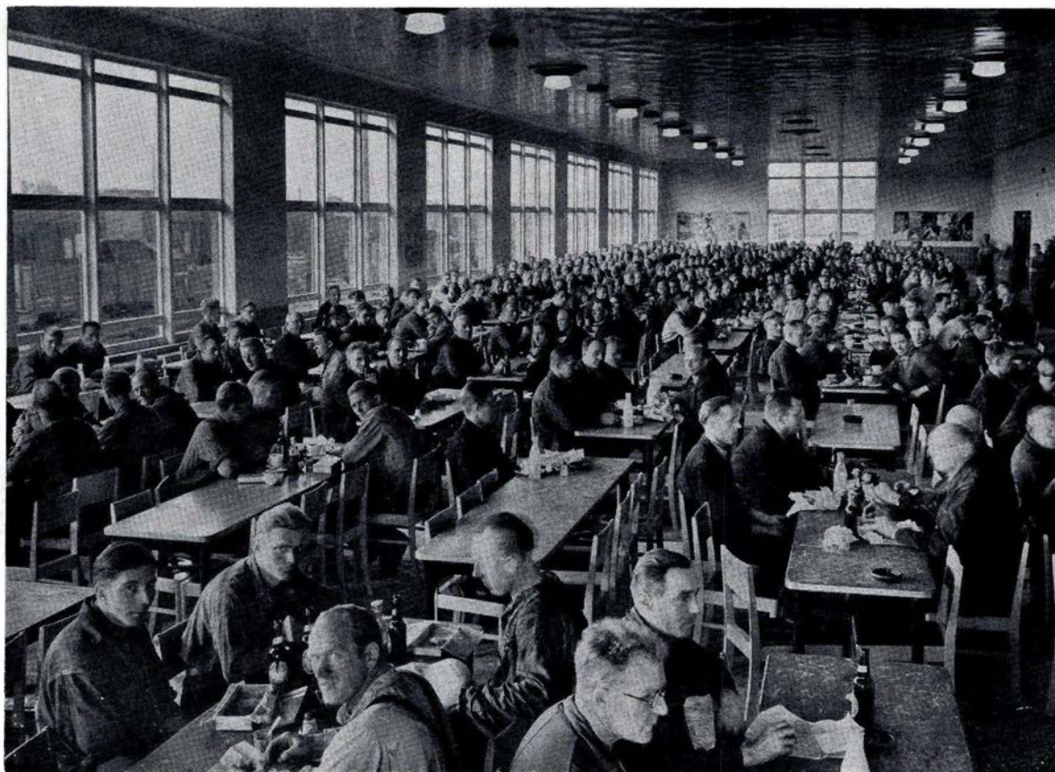
Fig. 225. Under Frokosthvilet i det nye Marketenderi ved Centralværkstedet i København, opført 1941.
