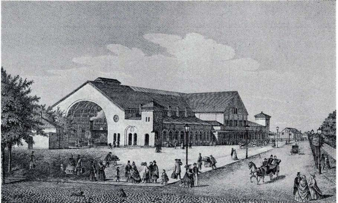
Fig. 190. Københavns anden Banegaard. Hovedbygningen laa Nord for Vesterbrogade, hvor nu Paladsteatret ligger. Den havde en stor Perronhal med 4 Spor. Afgangssiden laa mod Øst og Ankomstsiden mod Vest. Hallen var overdækket med en smuk Trækonstruktion, der blev anvendt som Forbillede for de store Træbuer i Hallerne paa den nuværende Banegaard.
