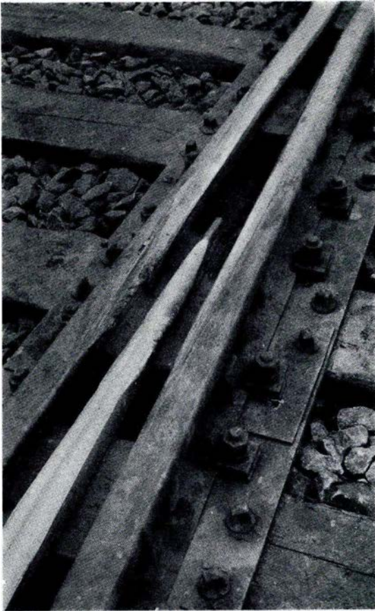
Fig. 94. Skinneskrydsning før og efter Paalægssvejsning.
