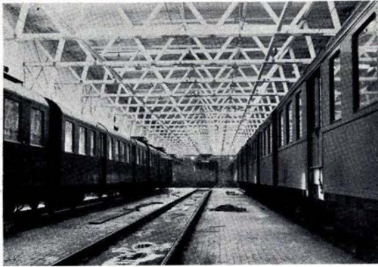
Fig. 220. Interiør fra Rengøringshallen i S-Togs Remisen ved Dybbølsbro i København, opført 1934. Bygningen, der er udført af Træbindingsværk og beklædt med Eternitplader paa Ydervæggene, er delt i to Afdelinger, den ene som Værkstedshal, den anden som Rengøringshal.
