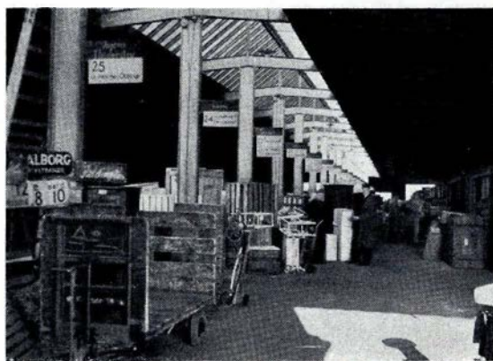
Fig. 232. Interiør fra Omladehal i Korsør. Hallens Ydervægge er udført af Træbindingsværk med Brædderbekledning.
