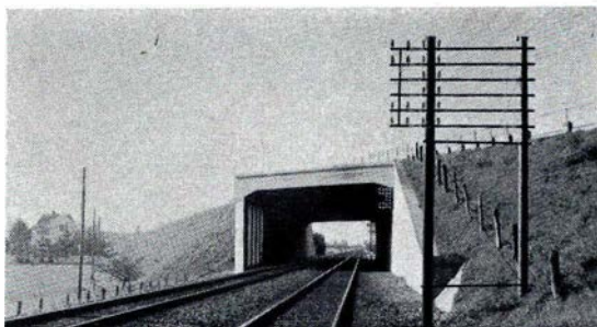
Fig. 54. Overføring for Hovedvej Nr. 1 Vest for Ringsted. Jernbetonportal med Lysvidde 10,0 m, Skæringsvinkel ca. 20°. Fuldført 1939.
