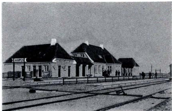
Fig. 199. Hampen. En Stationsbygning paa den jyske Hede. Opført 1917.
