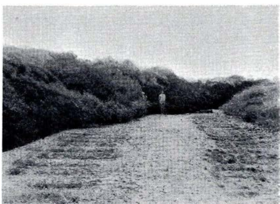
Fig. 25. Som en Bølge ruller de opskudte bløde Lag ud til Siderne og naar paa Billedet i en Højde af 4-5 m ind over Planum for det tidligere Dobbeltspor Fredericia-Pjedsted.
